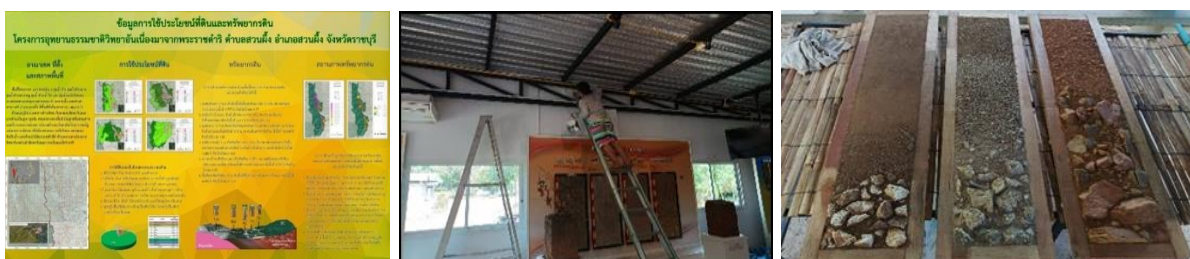
ภาพที่ ๑๖ จัดทำแผนที่ทรัพยากรดินโครงการอุทยานธรรมชาติวิทยาอันเนื่องมาจากพระราชดำริ ตำบลสวนผึ้ง อำเภอสวนผึ้ง จังหวัดราชบุรี ปรับปรุงซ่อมแซมผนังภายในอาคารพิพิธภัณฑ์ดิน รวมทั้งได้ดำเนินการเก็บตัวอย่างดินเพื่อจัดทำแท่งหน้าตัดดิน จำนวน ๓ ชุดดิน ได้แก่ ชุดดินบ้านไร่ ชุดดินทับเสลา และชุดดินท่ายาง
